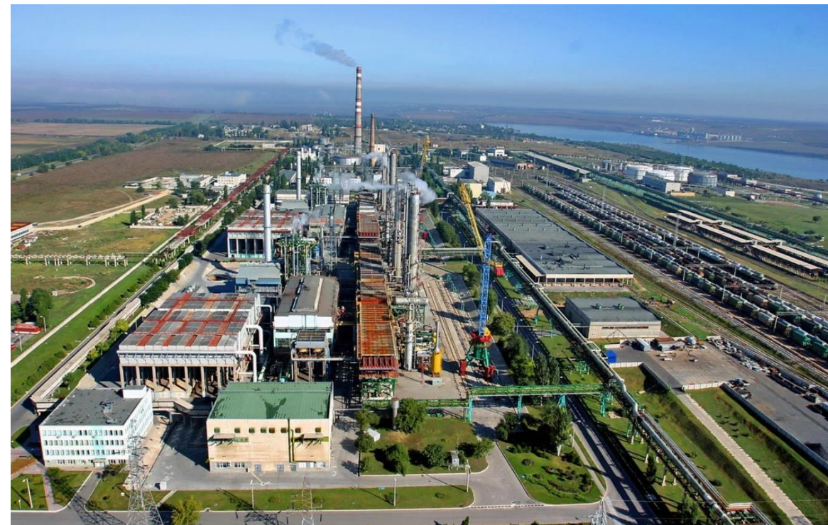
Одесский припортовый завод
